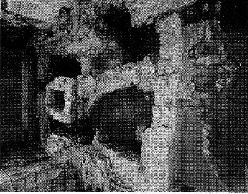
Fig. 28. Saint-Prex. Eglise. Vue du chœur. Photo Fibbi-Aeppli.
