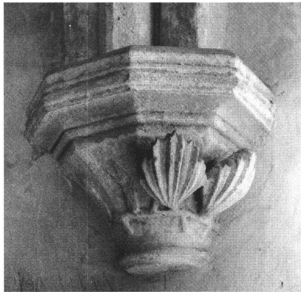
Fig. 23. Petit cloître de La Lance, cul-de-lampe recevant les nervures de la travée nord, contre le mur de l'église. Était-il prévu pour reposer sur une colonnette ? État en 1967.
