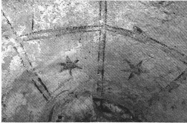
Fig. 14. Ancienne église de La Lance, mur gouttereau nord, sommet d'une des baies primitives obturées, détail du décor peint, état en 1997.
