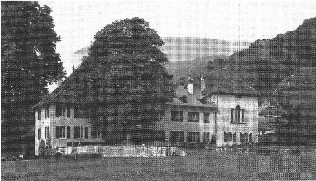
Fig. 32. Ancienne chartreuse de La Lance, la campagne du début du XIX e siècle vue de l'est, état en 2000. À gauche de l'arbre, l'aile Pourtalès de 1801, au centre, l'aile orientale des anciens bâtiments conventuels, à droite l'église-bibliothèque. Observer à droite de cette dernière, à l'arrière-plan, les murailles entourant les vignes élevées sous le prieur Jean de Berry dans les années 1370.
