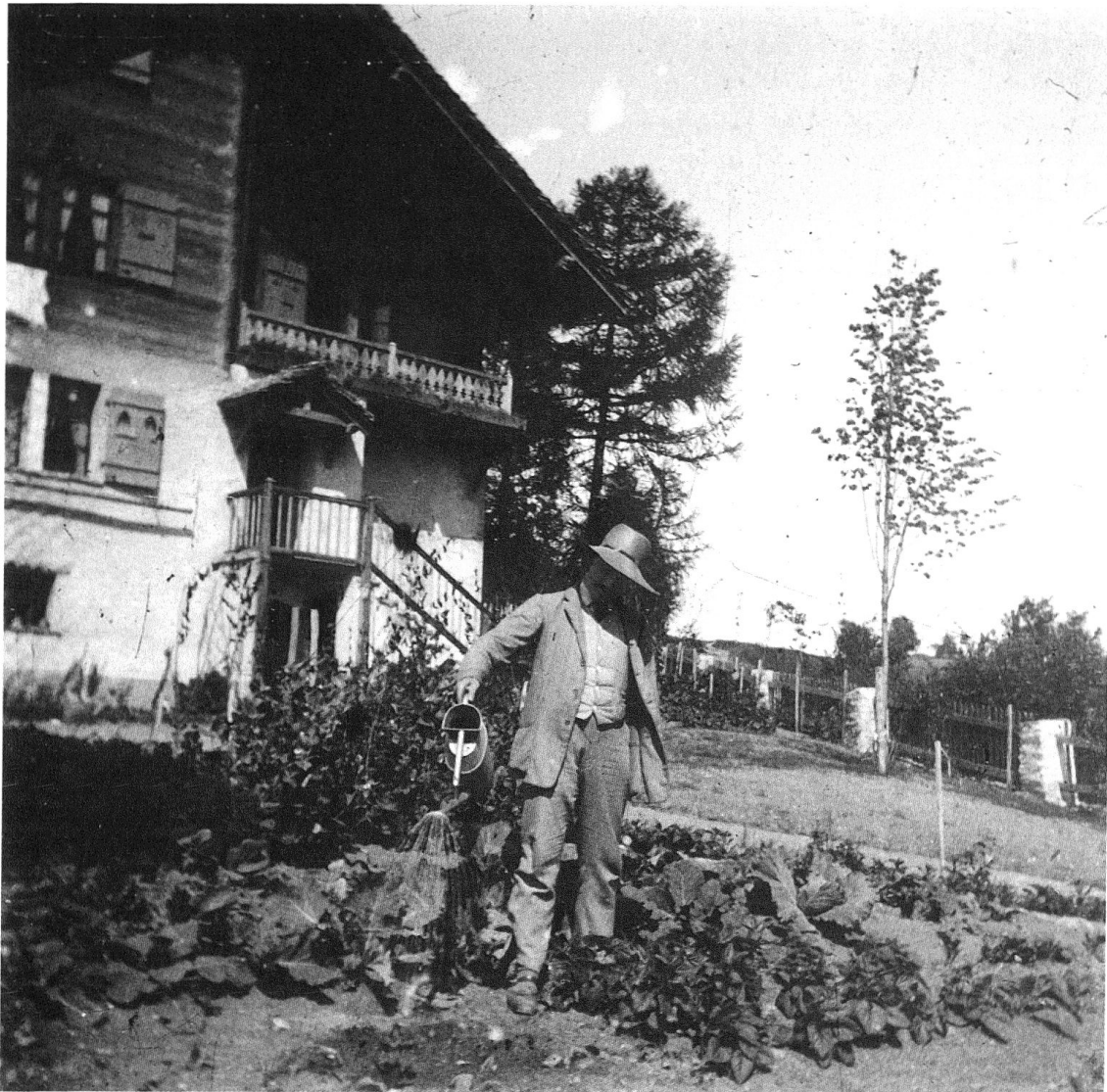
5 Albert Muret arrosant ses salades. Collection privée, photographie.
