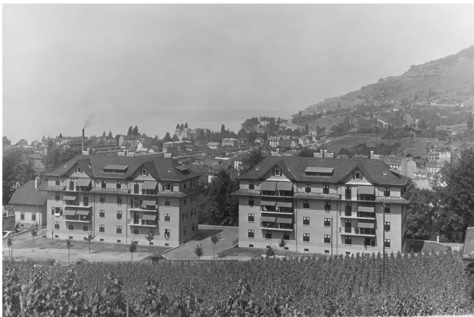
3 Les immeubles communaux de Charmontey, 1931, Archives du Service de l'urbanisme de la Ville de Vevey.
