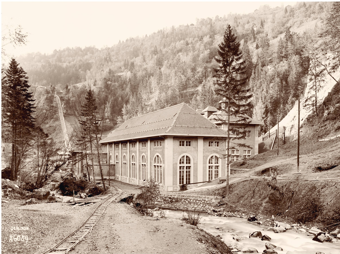
Le bâtiment abritant la salle des machines de l'usine de la Peuffeyre, reliée à la halte ferroviaire de Fontannaz-Seulaz par un funiculaire industriel visible en arrière-plan.
