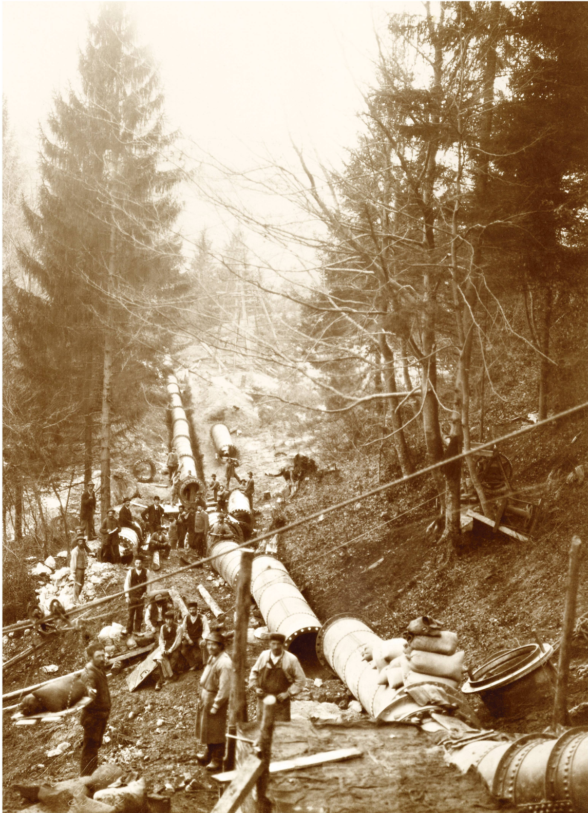
Travaux de construction de la conduite sous pression reliant le réservoir de Plan Sépey (1254 m.) à l'usine de Sublin (588 m).
