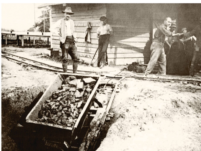
Différentes vues extérieures de l'exploitation de la mine de la Biardaz par la Société des mines de charbon d'Oron, vers 1918-1919.
