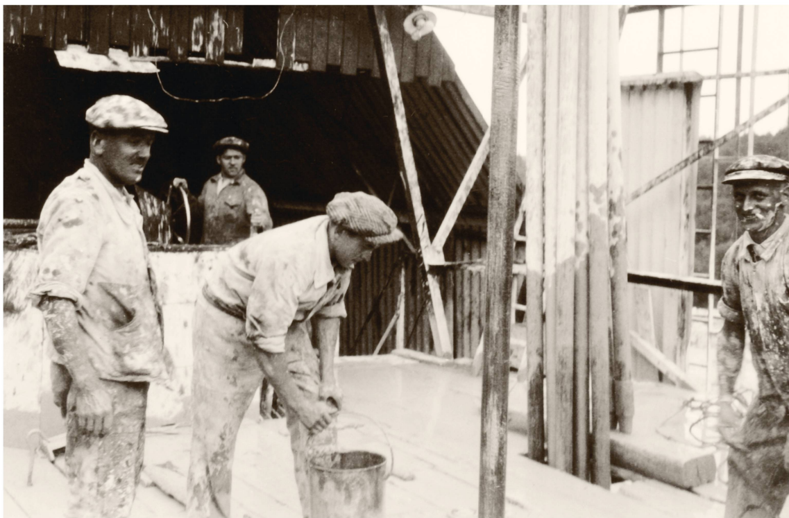
Ouvriers à l'œuvre sur le sondage de Servion, vers 1938-1939.
