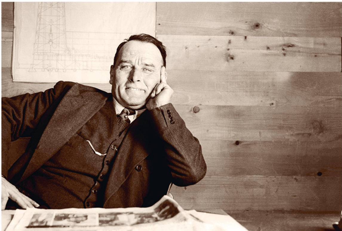
Ouvriers sur le forage et ingénieur dans son bureau sur le site de Servion. Vers 1938-1939.
