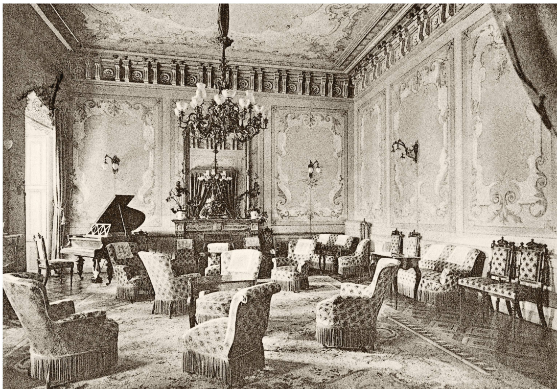
Éclairage électrique d'un salon de l'Hôtel Beau-Rivage à Ouchy (1908-1911).
