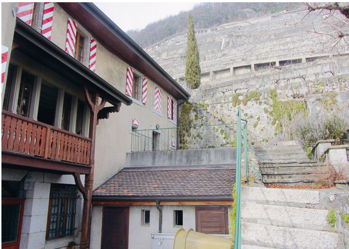
L'Abbaye du Dézaley, côté sud-est. L'entrée de la salle décorée par Auberjonois se trouve sur la galerie boisée à gauche.
