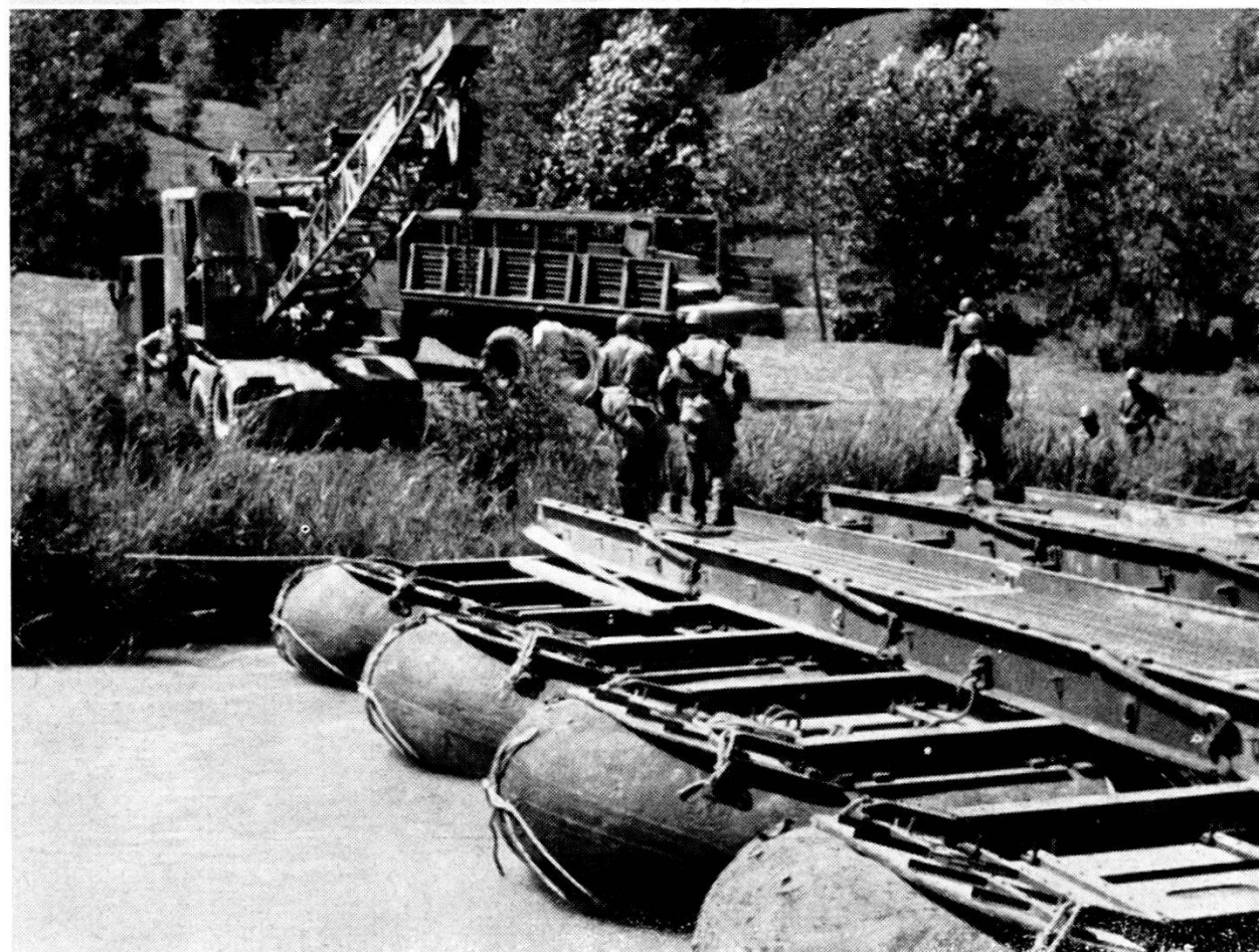
ITALIA: truppe della Divisione cor. Ariete: In alto : Sostegni pneumatici per ponti pesanti. In basso : Ponte pesante su pneumatici.
