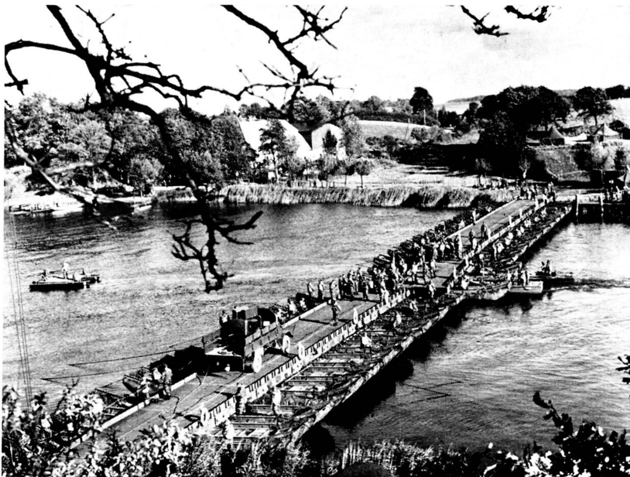
Pionieri della Bundeswehr costruiscono un ponte su pontoni.
