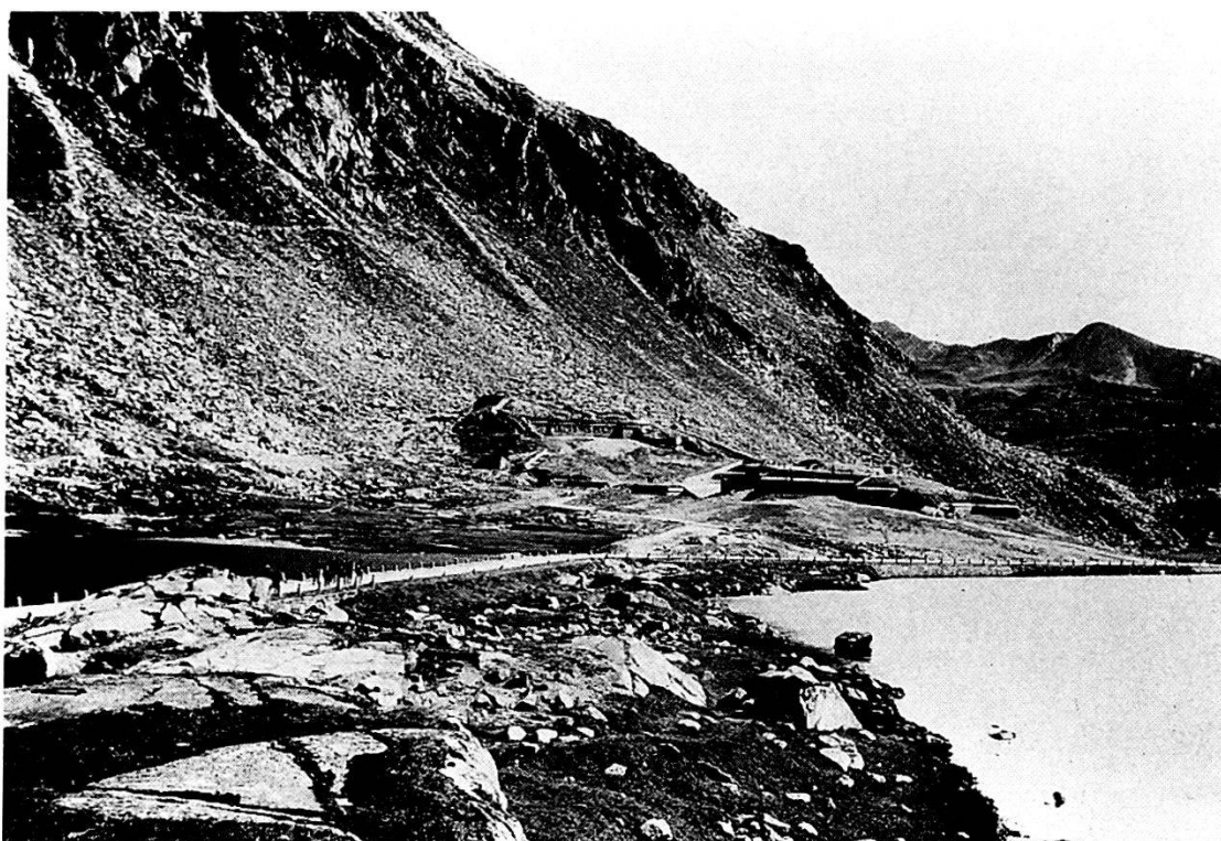
Forte Ospizio visto da nord.
