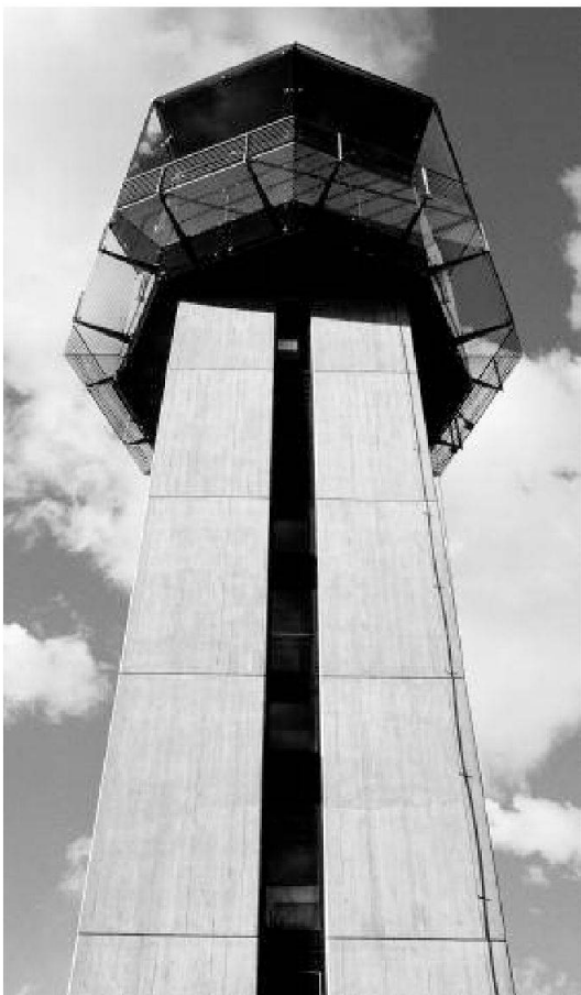
Nuova torre di controllo della base aerea di Locarno
