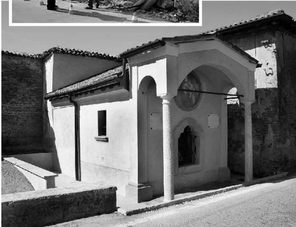
L'Ossario prima e dopo il restauro.
