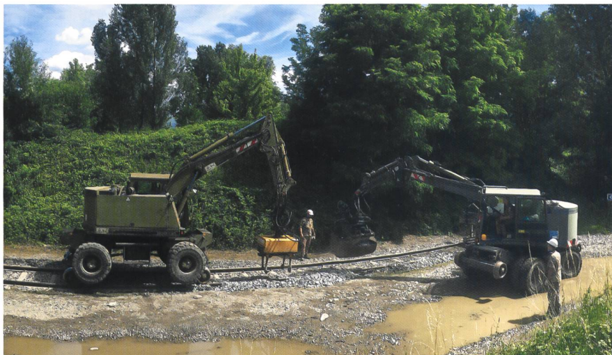
Ripristino dei binari
