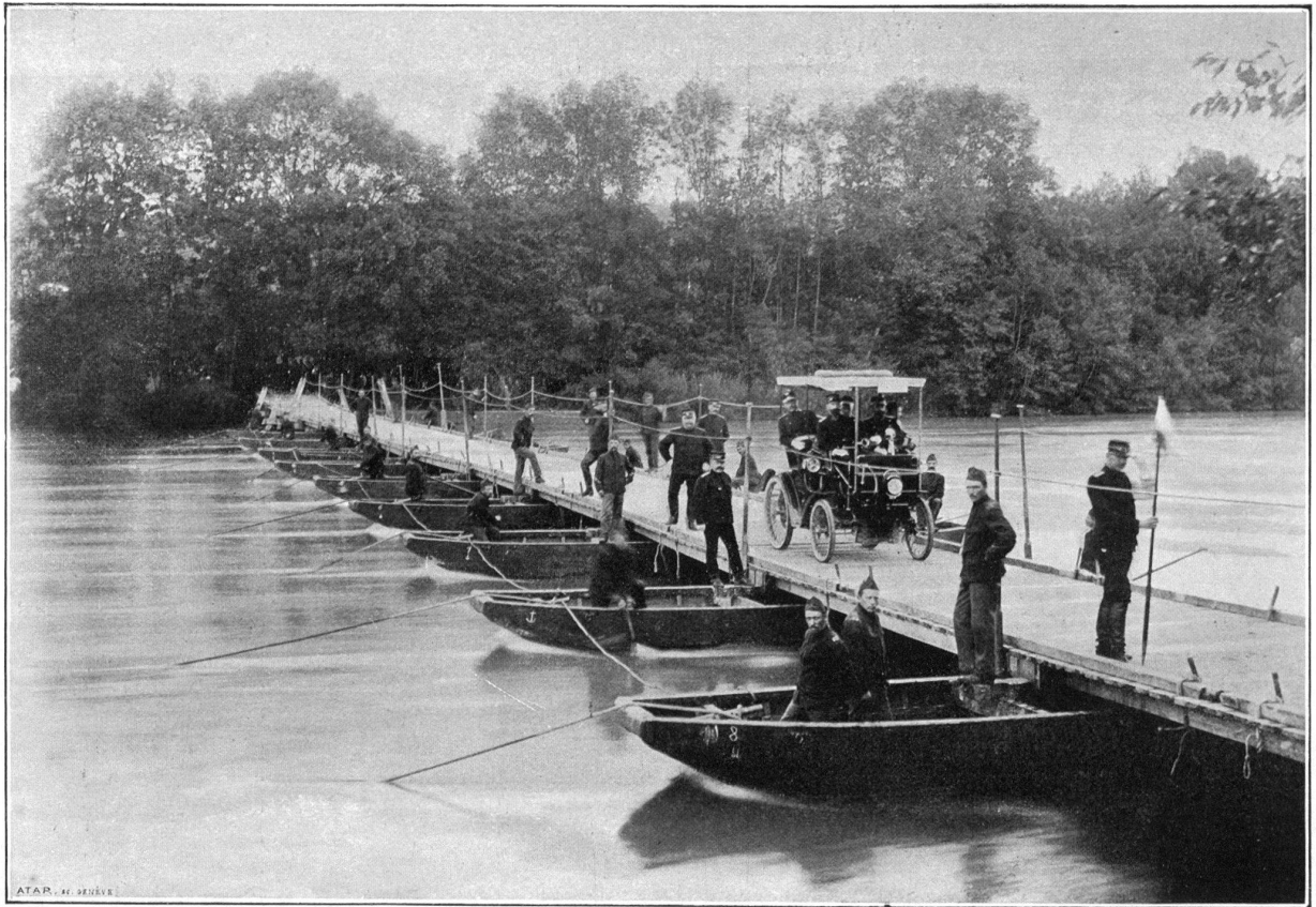
Passage d'un pont de pontons sur l'Aar, à Wangen, par la voiture Peugeot.
