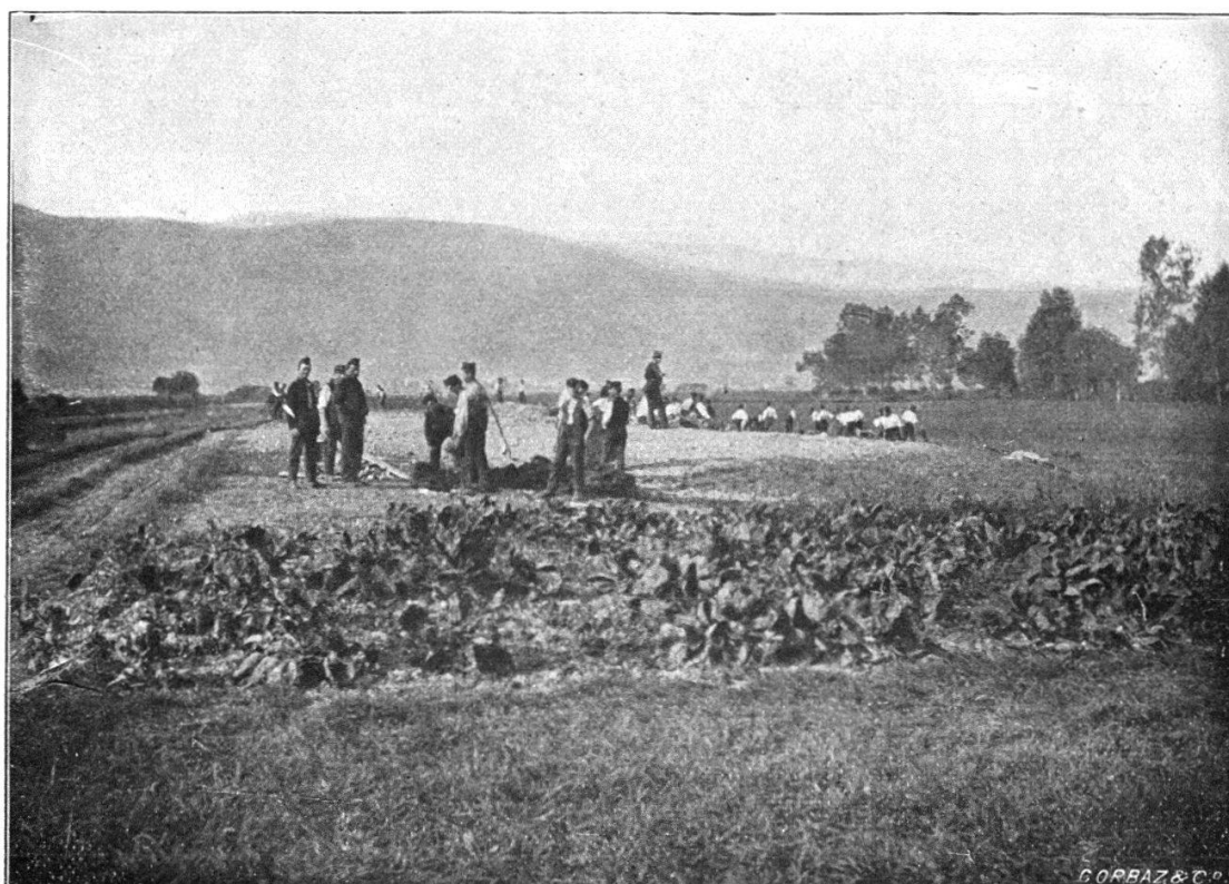
2. Abri d'avant-poste en construction.
