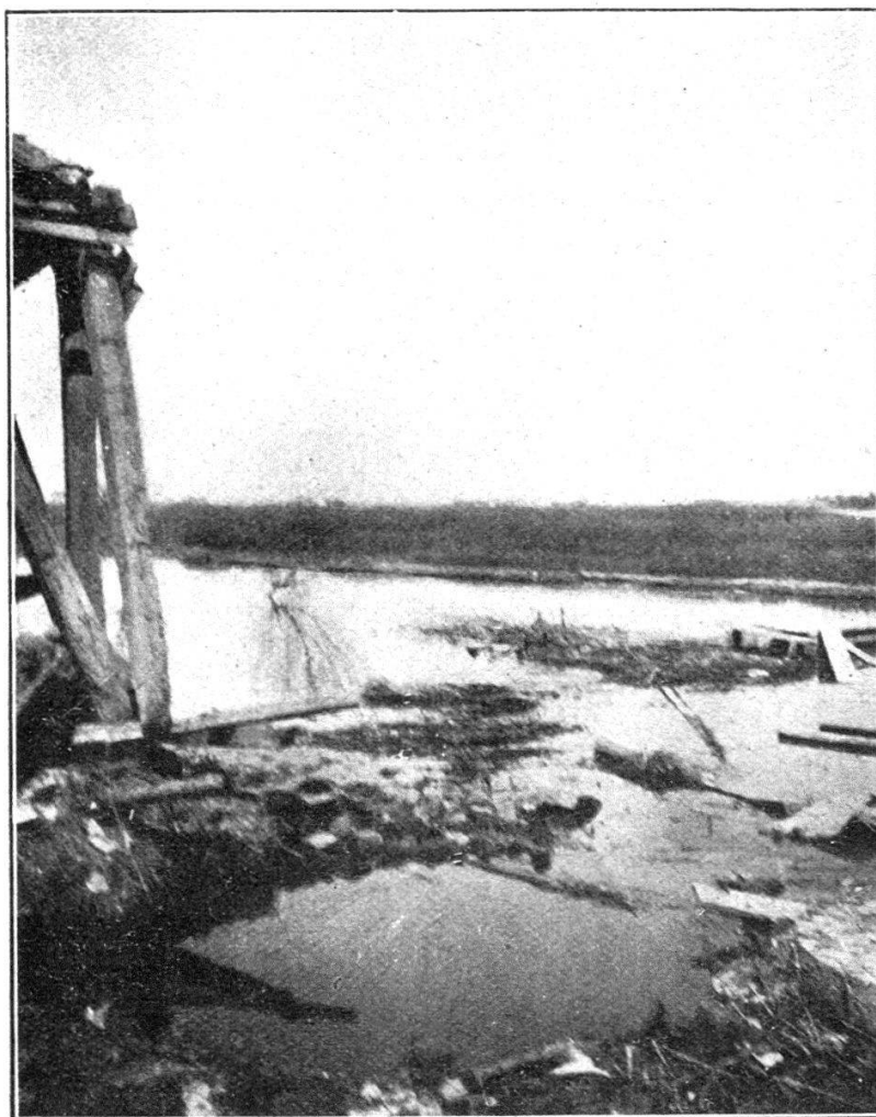
Un poste d'écoute en pleine inondation.
