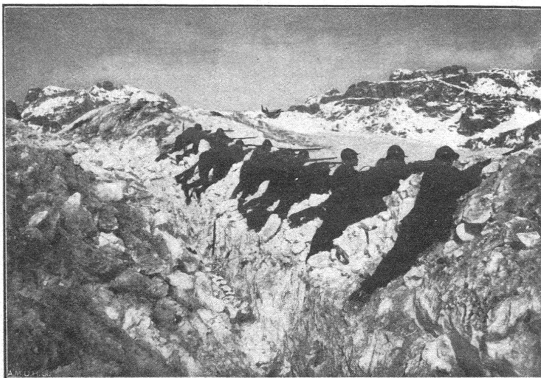
Tranchée sur la Cime Lana.
