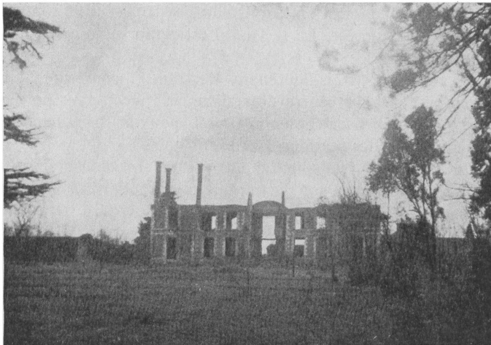
Dury 1940 : Ruines du Château, P.C. du Centre de Résistance, détruit dans les combats du 6 juin 1940. Vue de la face Nord.
