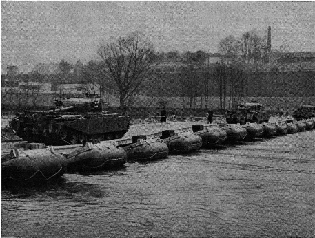
Fig. 5. — Pont sur appuis flottants, capacité 50 t.
