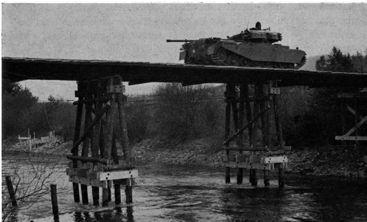
Fig. 6. — Pont de fortune (DIN), capacité 50 t.
