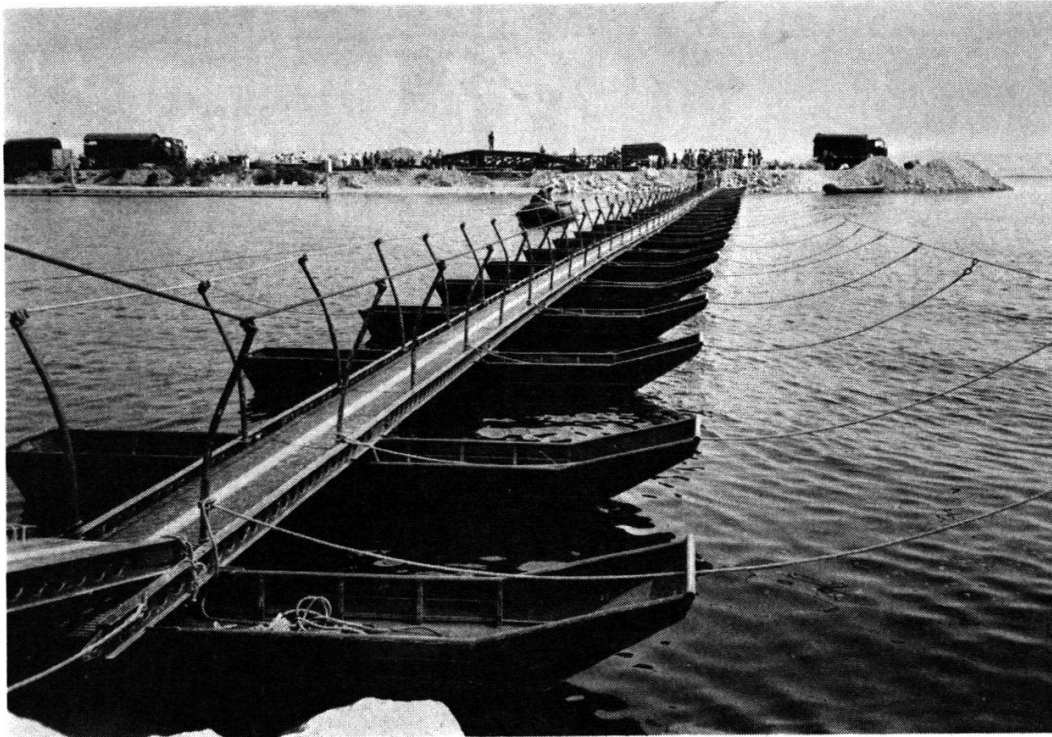
Le génie a construit une passerelle 58
