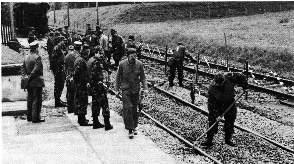
Inspection d'un chantier de réfection de voie. (Photo: sdt Jacquat G.)
