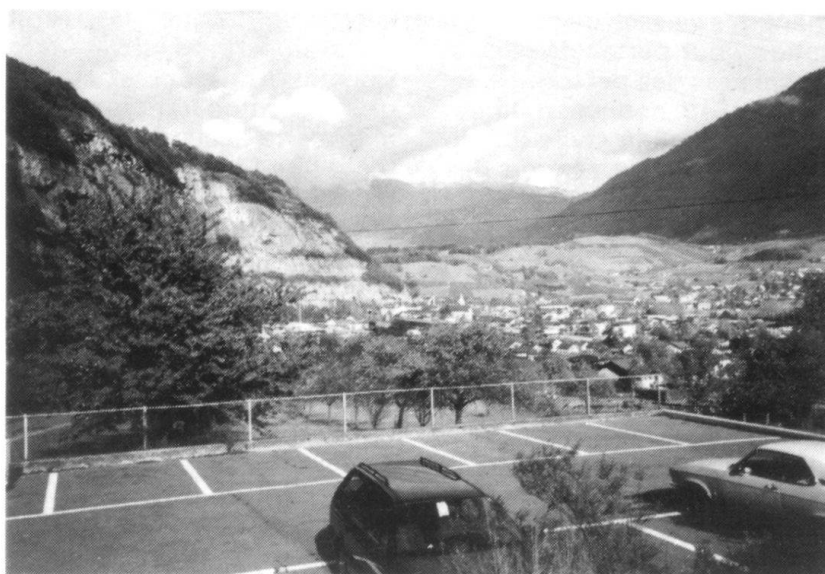
Un exemple d'imbrication civilo-militaire, le secteur du défilé de Saint-Maurice en Valais.
