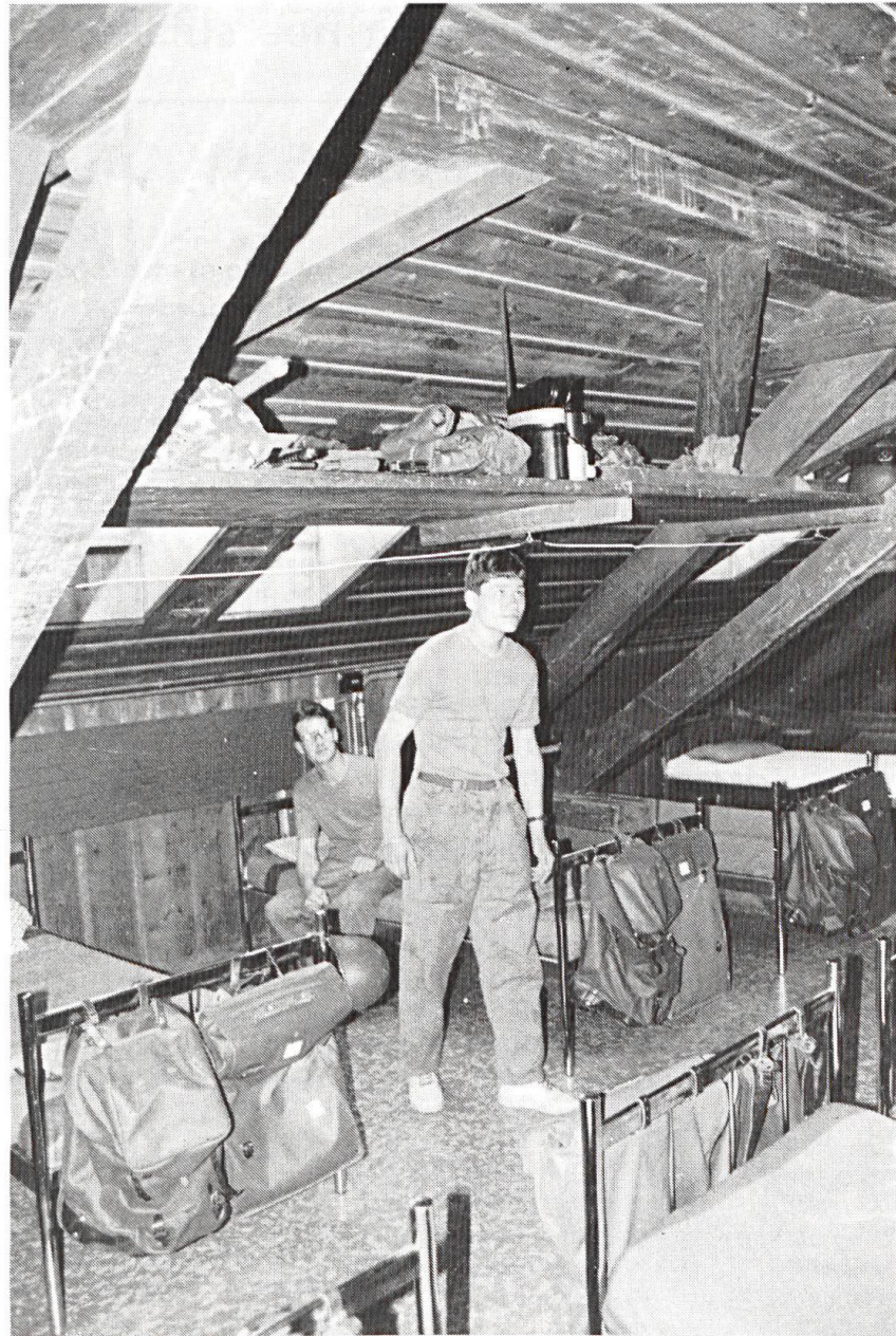
Une acceptation de l'initiative sur les places d'armes empêcherait de moderniser les vieux cantonnements de la caserne d'Herisau, qui sont à la limite dangereux...
