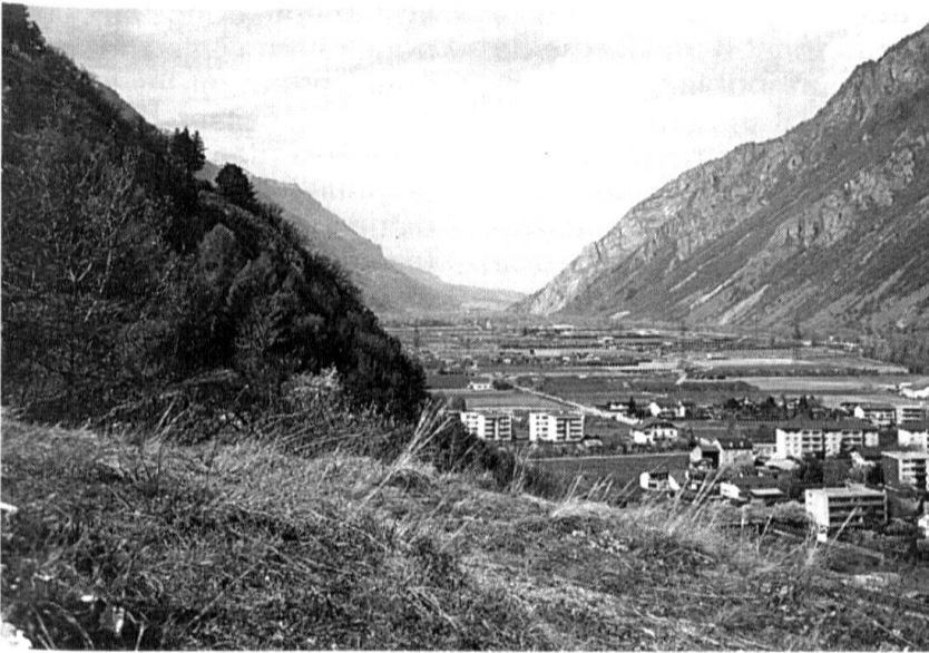
Martigny, vue en direction de Saint-Maurice.
