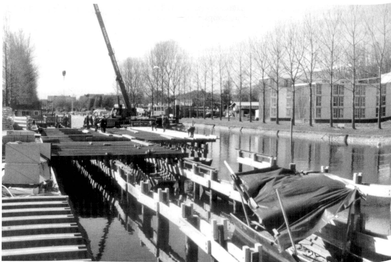
Finition du plancher.
