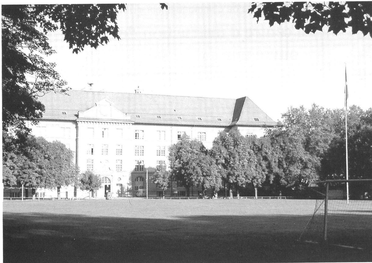
La caserne Mezener à Berne, lieu de la nouvelle école de conduite unité.
