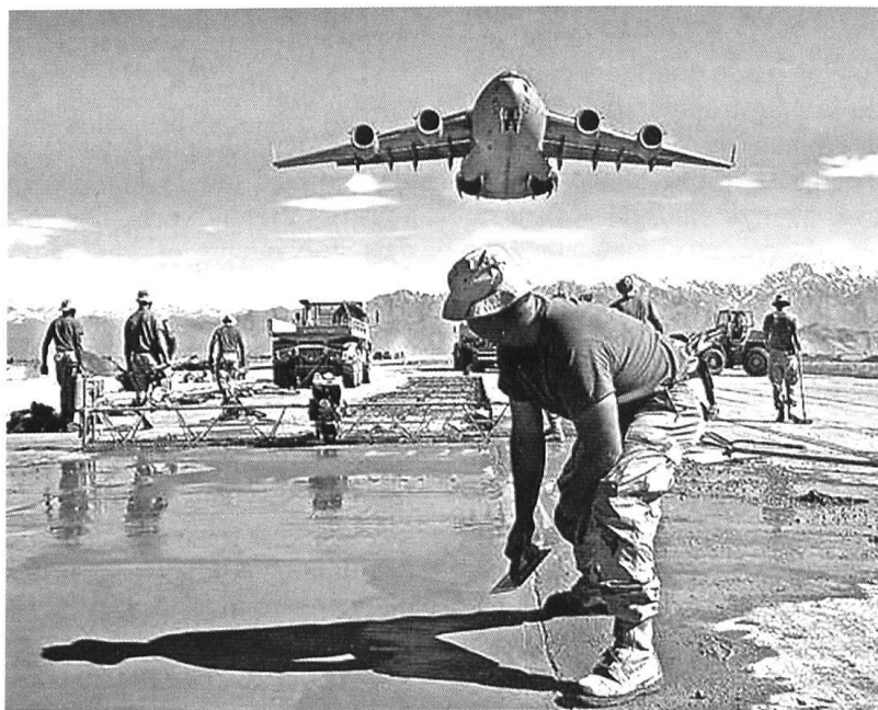
Remise en état par le génie de l'aérodrome de Bergram.
