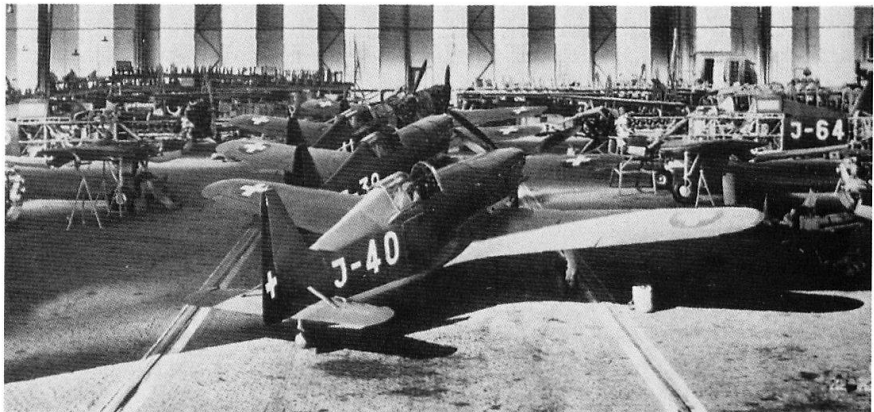
Le Morane D-3800/01 représente la plus grande série d'avions produites en suisse.
