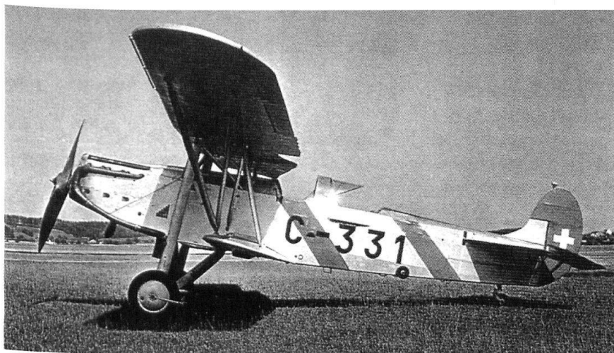
En 1930, la Suisse construit sous licence 45 Fokker-CV, avec un moteur Hispano-Suiza de 750 CV; l'avion peut atteindre une vitesse de 250 km/h.
