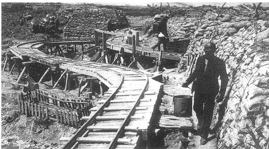
*Durant les combats, les tranchées sont consolidées à l'aide de sacs de sable et elles doivent être régulièrement reconstruites. Des wagonnets, poussés sur un chemin de fer Decauville, facilitent l'acheminement du matériel et du ravitaillement.*
