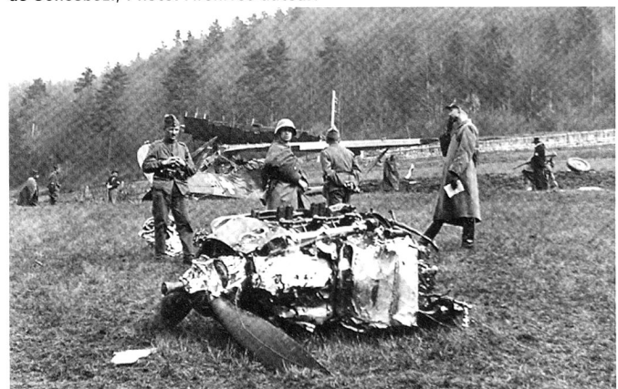
Le moteur du C-35. Bien visible, le canon 20 mm dans le capot de l'hélice à laquelle il manque une pale. Photo: Archives auteur.
