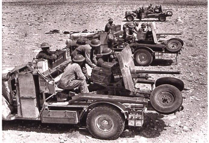
L'armée britannique a expérimenté avec la fixation de canons d'infanterie ou antichars sur les camions tracteurs, surnommés « portees » et permettant ainsi de réduire le temps de mise en batterie. Ces canons de 2-lbs ou 40 mm ont été installés en atelier sur des camions Chevrolet. Ces engins sont les ancêtres des « technicals » contemporains.
