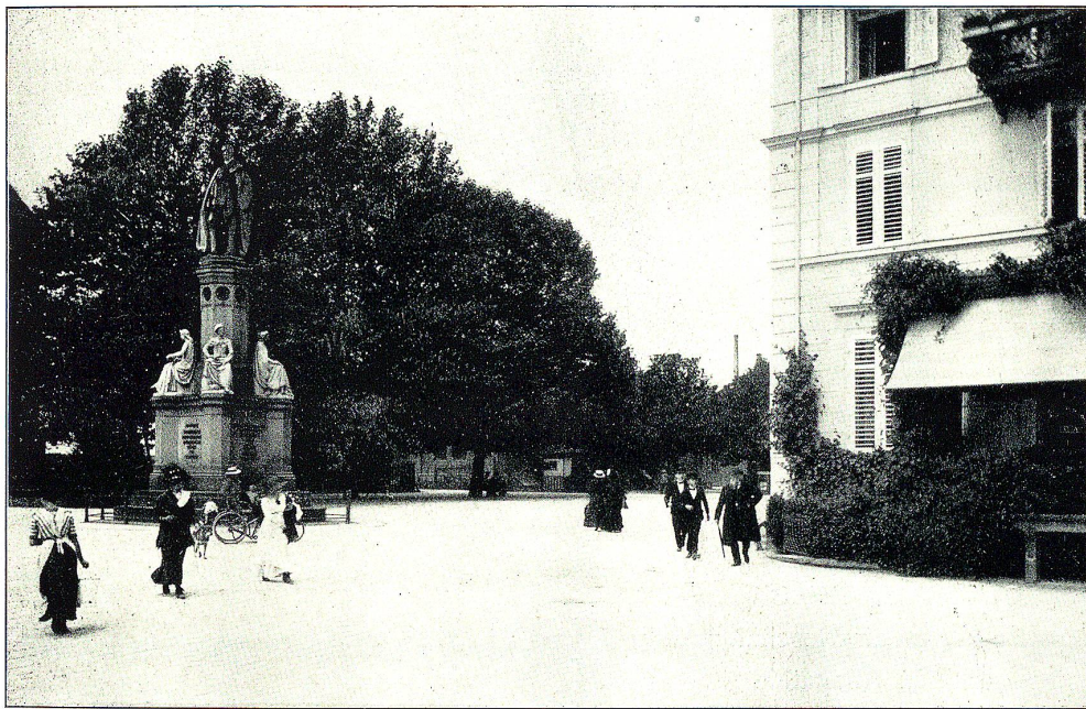
Die drei Platanen beim „Bayerischen Hof“ in Lindau, welche leider dem neuen Bahnhofbau zum Opfer fallen.
