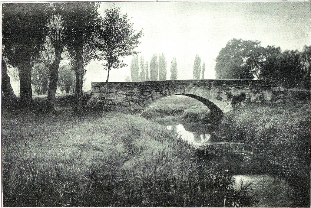
Brücke zwischen Horn und Rorschach
