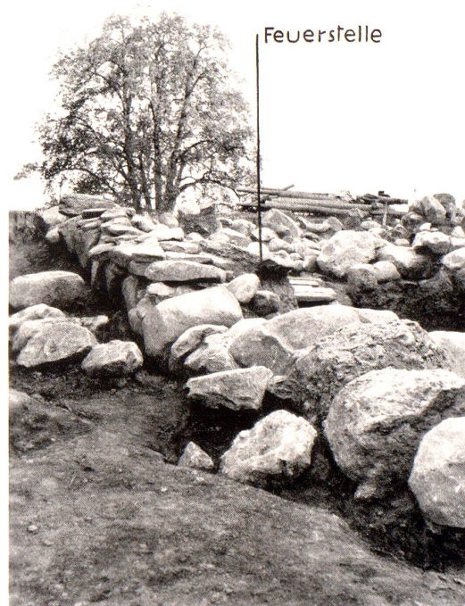
Abb. 4. Westliche Trockenmauer in Feld I.
