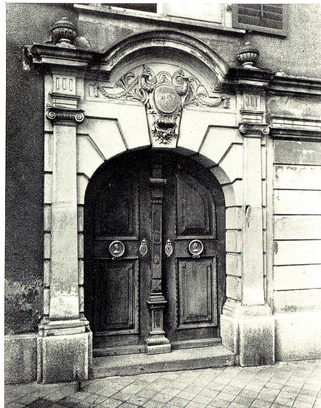
Klassizistisches Portal des Hauses «Im Hof»
