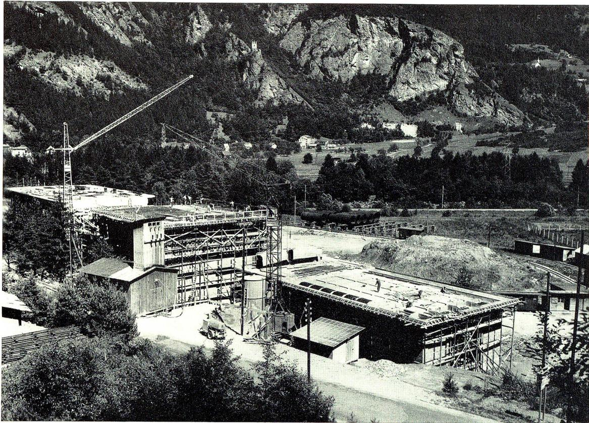
Die neu erstehende Zentrale von Rothenbrunnen, in welcher die Wasserkräfte in der letzten Gefällsstufe bei einer installierten Leistung von 111 000 kW ausgenützt werden
