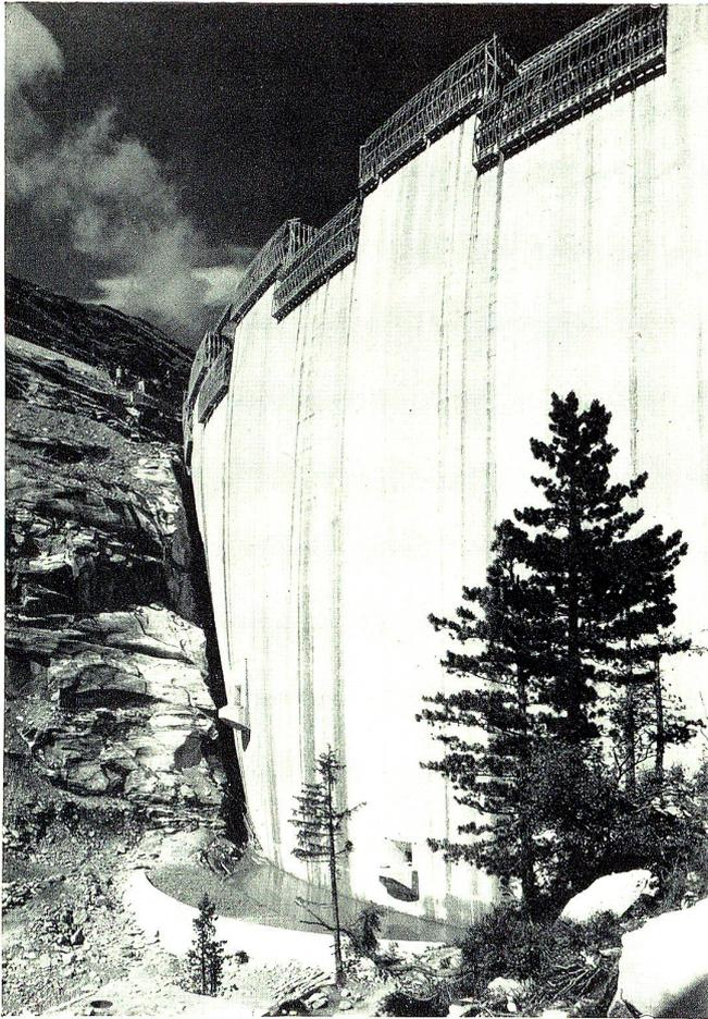
Der elegante Baukörper von 650 000 m<sup>3</sup> Beton strebt von der Sohle 150 m in die Höhe
