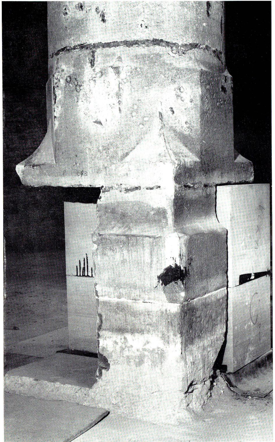
Die teils stark beschädigten Pfeilerbasen der Erdgeschoss-Säle mit ihren grossen Traglasten der Gewölbe und der oberen Stockwerke mussten sorgfältig quadrantweise durch neue Werkstücke ersetzt werden, die am Bau nachgehauen wurden. Dabei wurde den Isolationsmassnahmen gegen die werkzerstörende aufsteigende Feuchtigkeit grosse Beachtung geschenkt.
