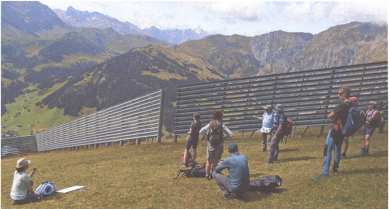
Lawinschutzwand, die der Verfrachtung von Schnee dient: Durch die Öffnungen strömt Wind, sodass der Schnee an Stellen geblasen wird, wo er nicht zur Lawine werden kann.
