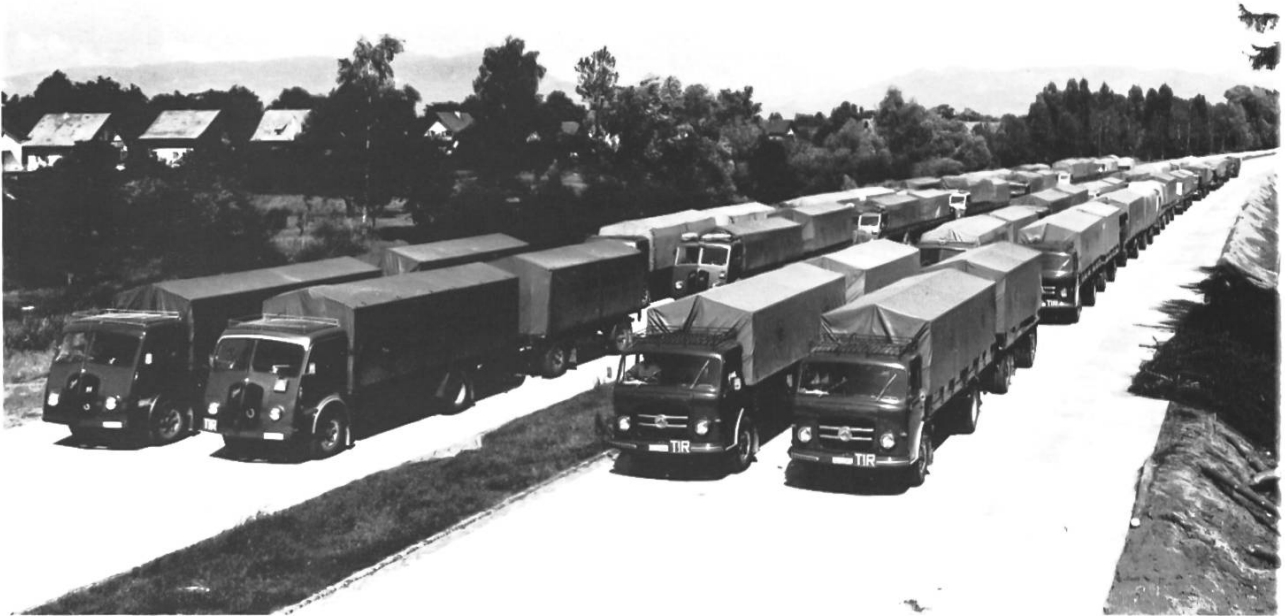
Denkwürdige Photos auf der fertig erstellten Autobahn N1 bei St.Margrethen vom 6. Juli 1963.
