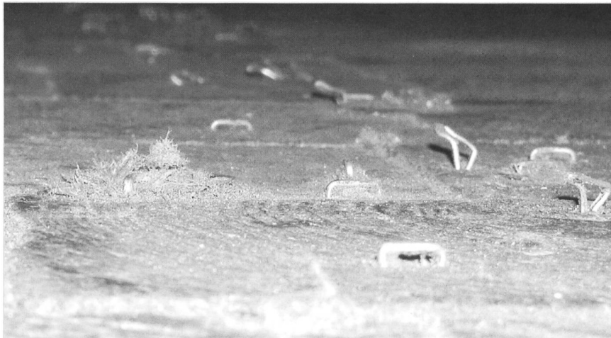
Hunderttausende dieser Agraffen waren im Klötzliboden und mussten einzeln herausgezogen werden
