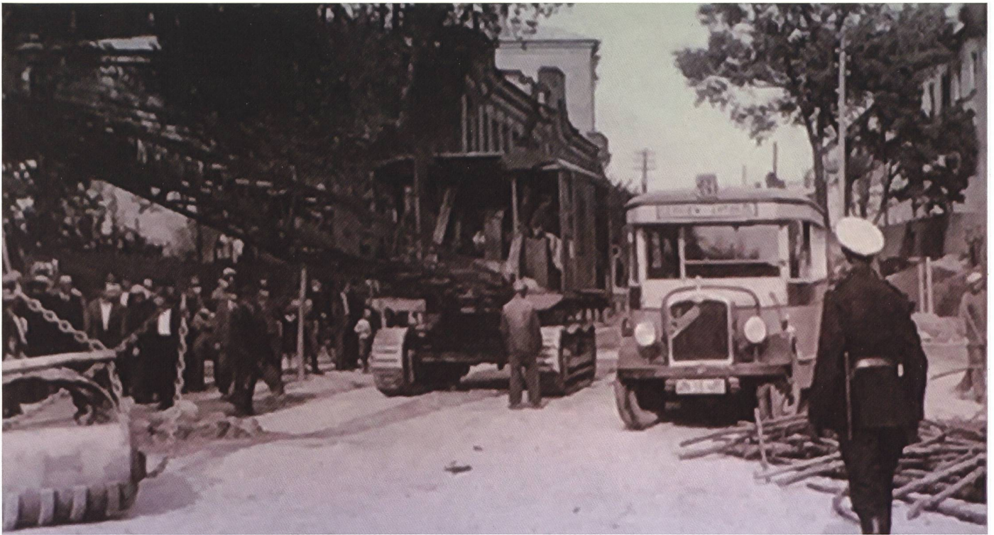
Den Saurer Wagen zuliebe mussten die Strassen ausgebaut werden. Die Busse hatten zu sehr unter den vielen Schlaglöchern gelitten.
