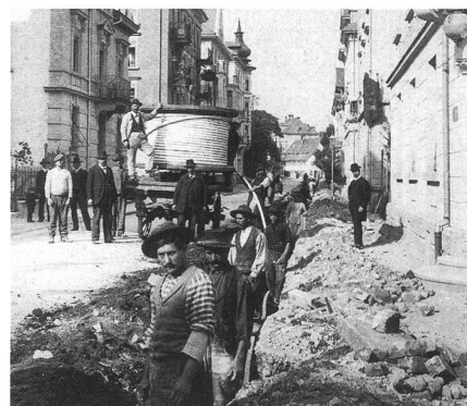
Italienische Gastarbeiter bei der Kabelverlegung in Rorschach (1912)
