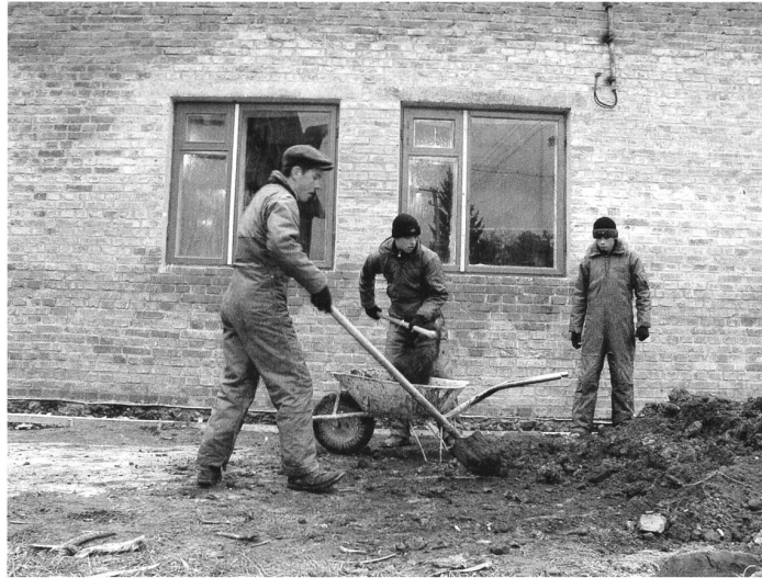
Toilettenbau für Waisenhaus
