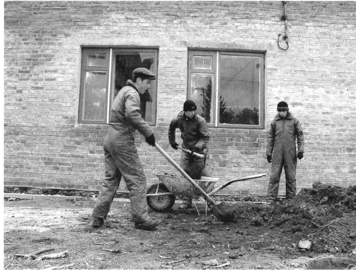
Toilettenbau für Waisenhaus
