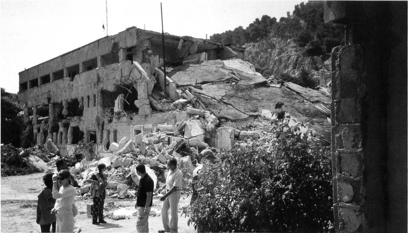
Zerstörtes Verwaltungsgebäude, das Yassir Arafat jeweils als Aufenthaltsort diente. Bei der Bombardierung im Jahr 2002 starben 13 Menschen.
