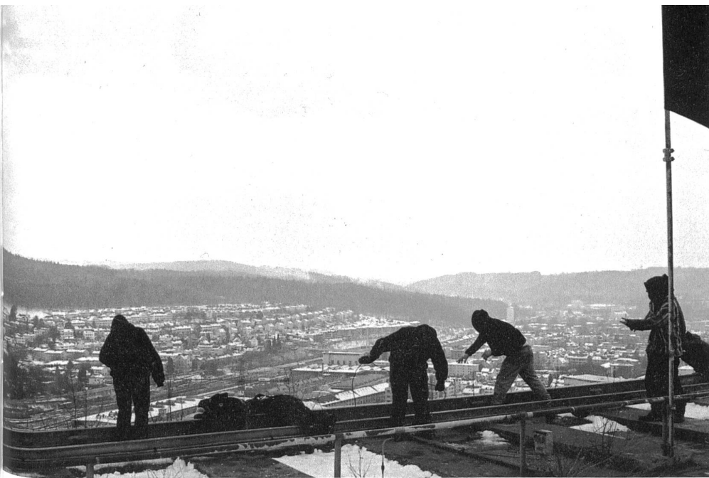
Auf dem Dach des besetzten Sulzerhochhauses, Februar 2004
