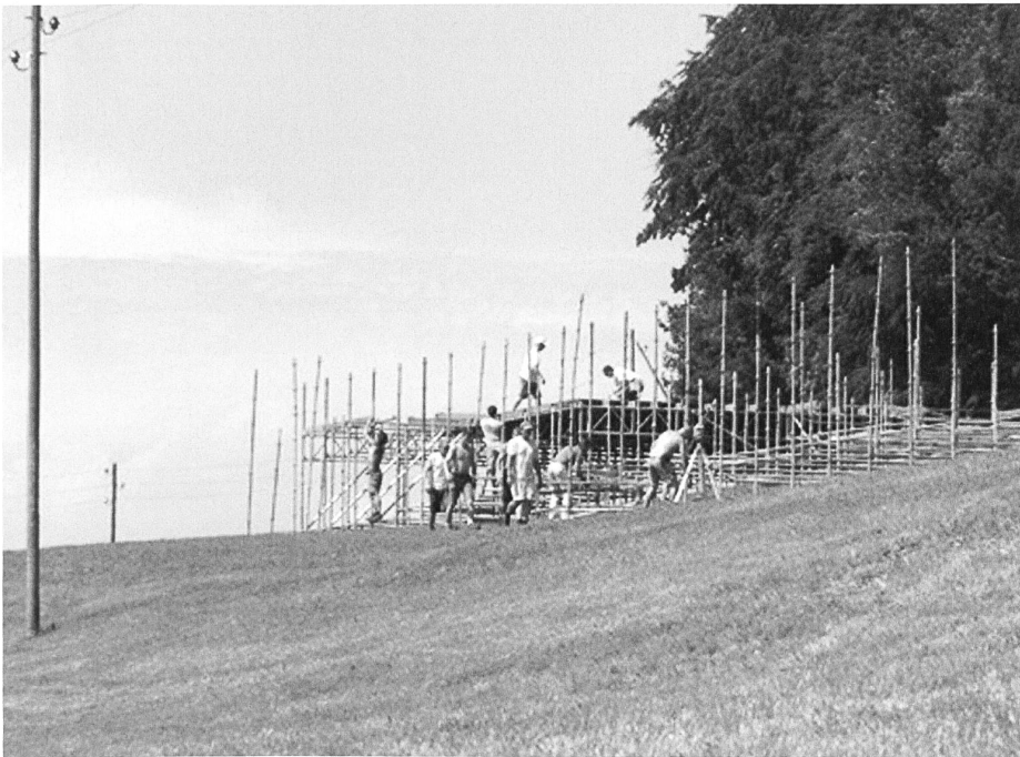
Beim Bau des SVP-Tempels in Tufertschwil
