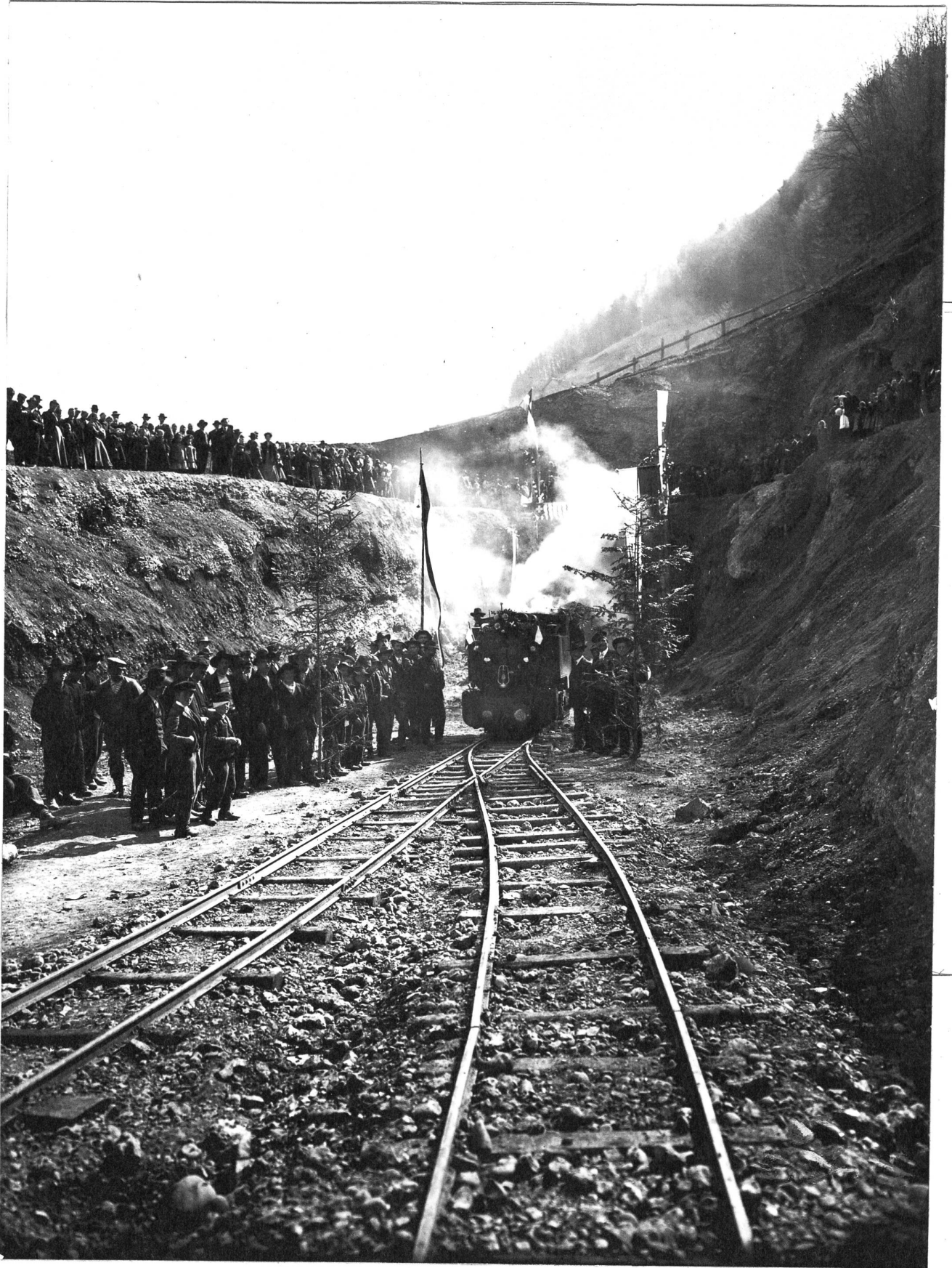
Festzug nach dem Durchbruch des Wasserflutunnels im April 1909.
