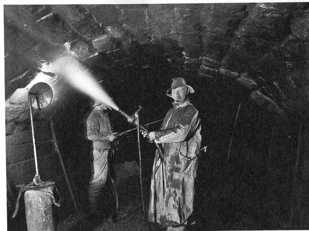
Ein Tunnelarbeiter «wäscht» das Mauerwerk mit einem Sandstrahlgebläse.
