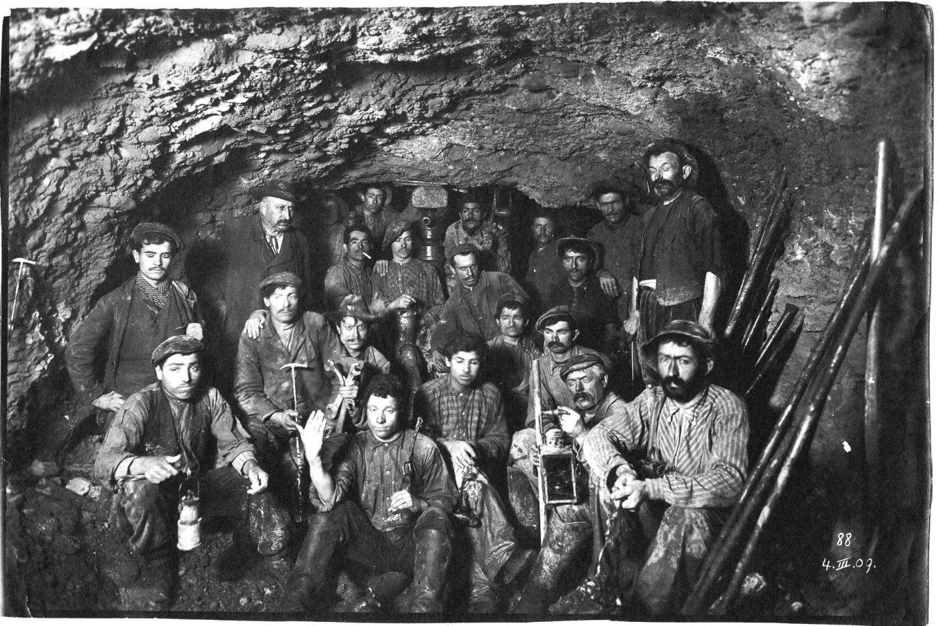
Bauarbeiter im Wasserflutunnel im März 1909.
