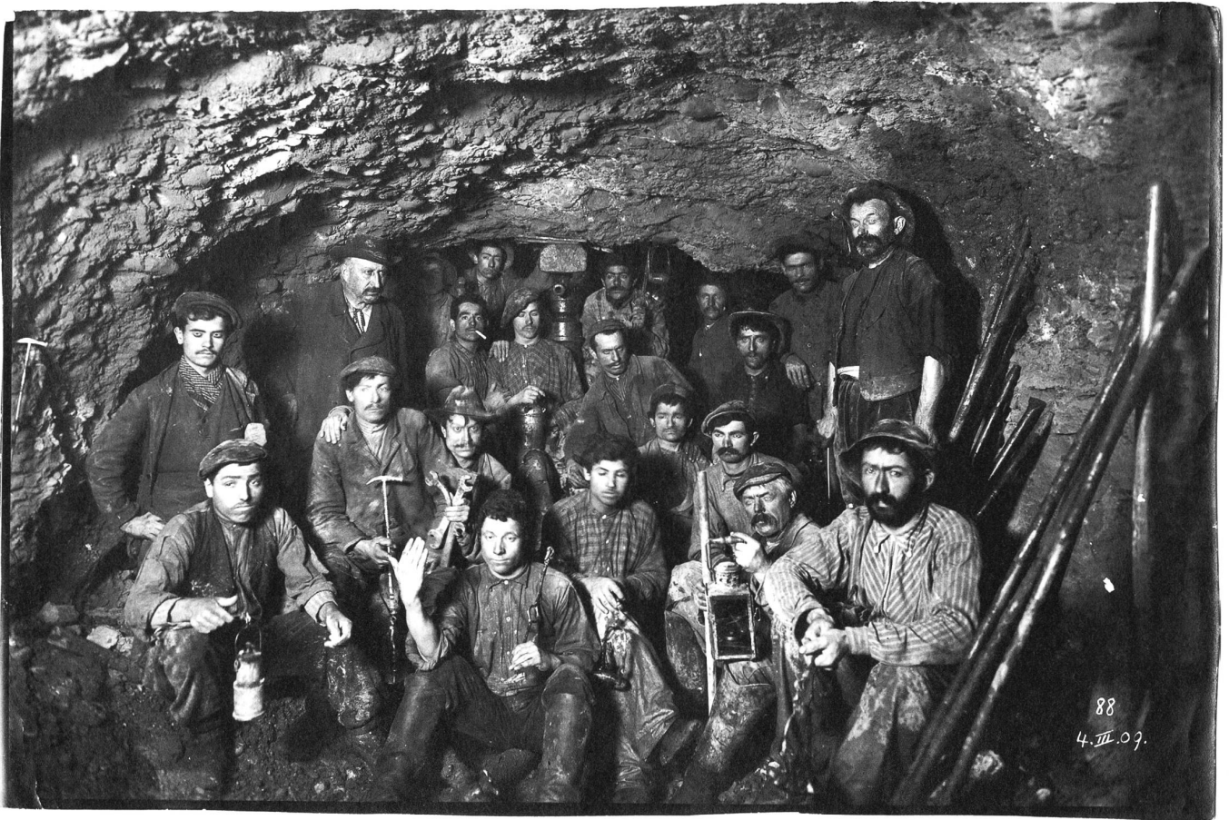
Bauarbeiter im Wasserflutunnel im März 1909.
