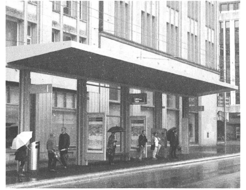
Das Dach an der Kornhausstrasse
